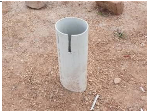
Ranura en el tubo de recubrimiento para acomodar el cableado en el cabezal del pozo.
