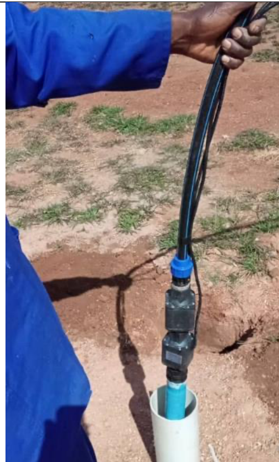
Instalación en tubo de recubrimiento de 90mm
