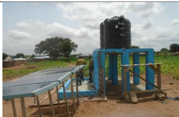
4 bombas ZL50-20N en serie alimentadas por 4 paneles de 100 Watt. El agua se utiliza para el suministro de agua comunal
